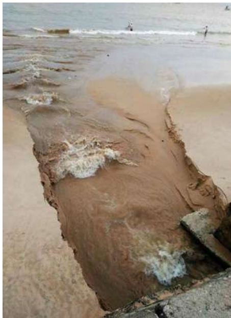
Figura 1: Banhistas não sabem se o que veem é esgoto ou água pluvial
