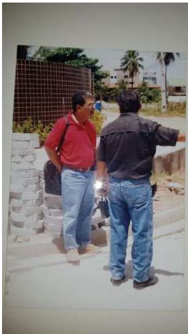
Figura 8 - Douglas Monteiro, então presidente da AMI, nas obras de calçamento do bairro
